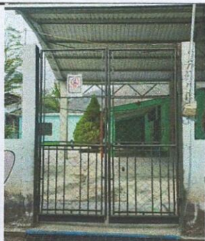
FOTO 5: Sustrucción de portón con malla por portón de metal con chapa de 2.00 x 2.60
