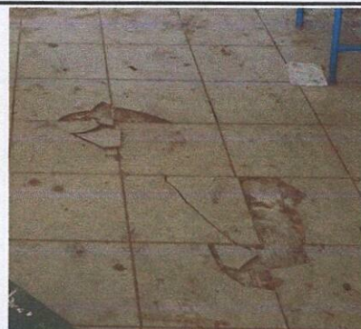
FOTO 4: Sustrucción de piso cerámico por piso cerámico en baños
