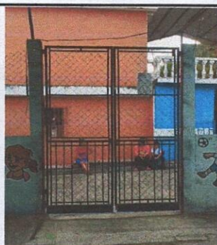
FOTO 5: Sustrucción de portón con malla por portón de metal con chapa de 2.00 x 2.60
